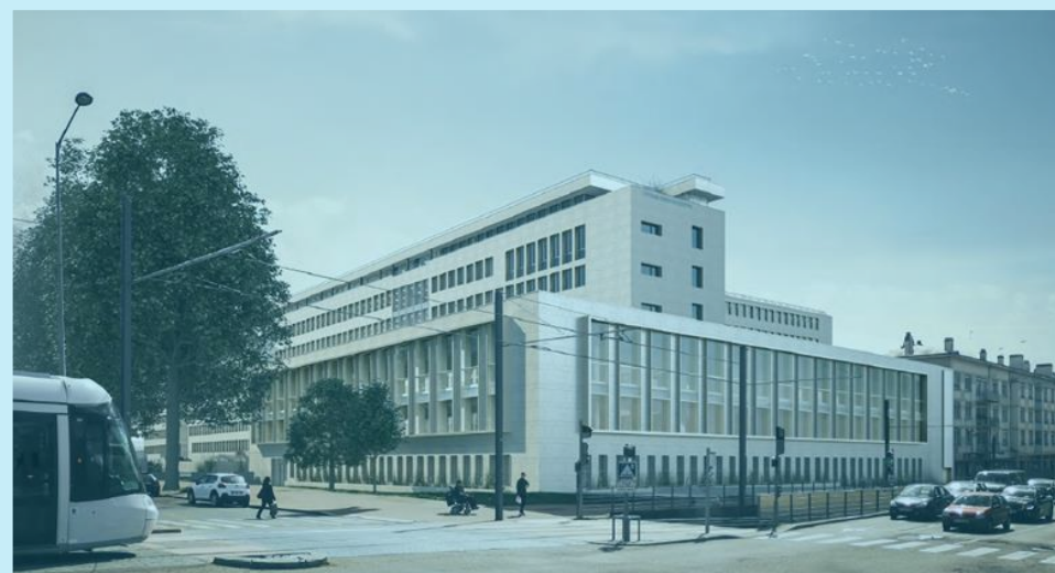
MOA / Client : DDTM 76 Chantier de rénovation de la Cité Administrative Saint-Sever.
